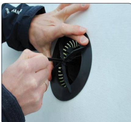
Dæksel trækkes stramt ned til undertaget
