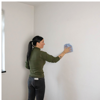
Vask grundigt overfladen af. Tjek om væggen er i vater/lod.
